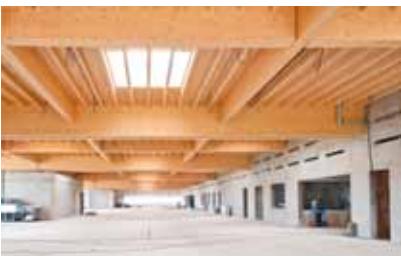
Beispiel: Dachkonstruktion des Flughafens Airport Kassel mit STEICO LVL.
