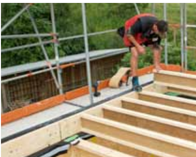
Als setzungssichere Randbohle (in Kombination mit STEICOjoist)
