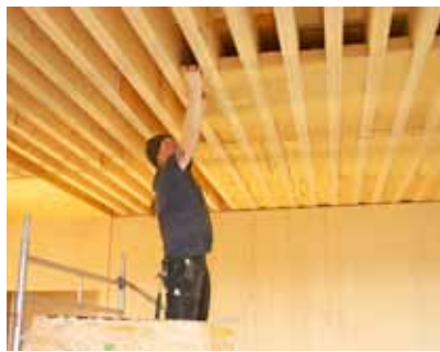
Weit spannende Deckenkonstruktionen im Objekt- und Gewerbebau
