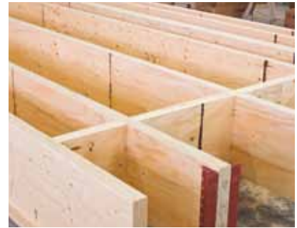
Vorfertigung von Hohlkasten-Deckenelementen.
